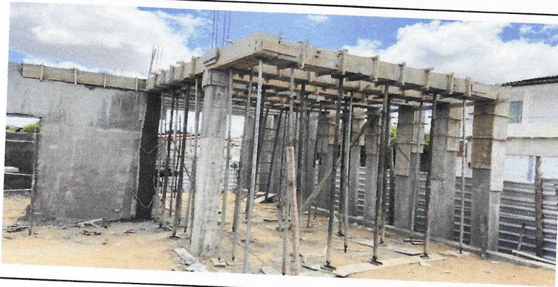
EXECUÇÃO DE REBOCO INTERNO
