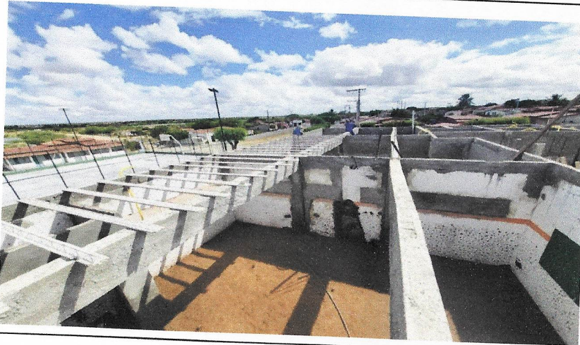
APLICAÇÃO DE SELADOR ACRILICO
