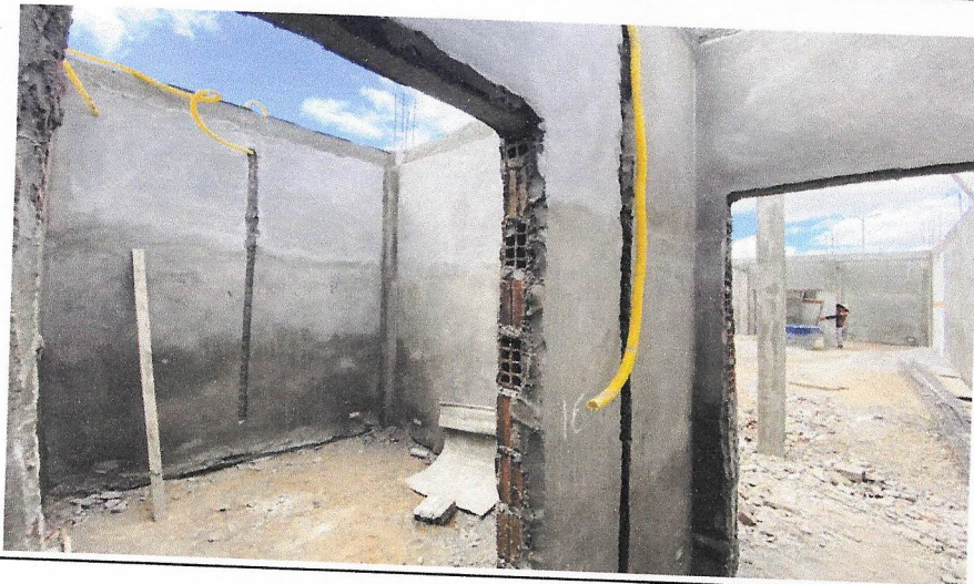
EXECUÇÃO DE PONTOS ELETRICOS ( CAIXAS 4X2 )
