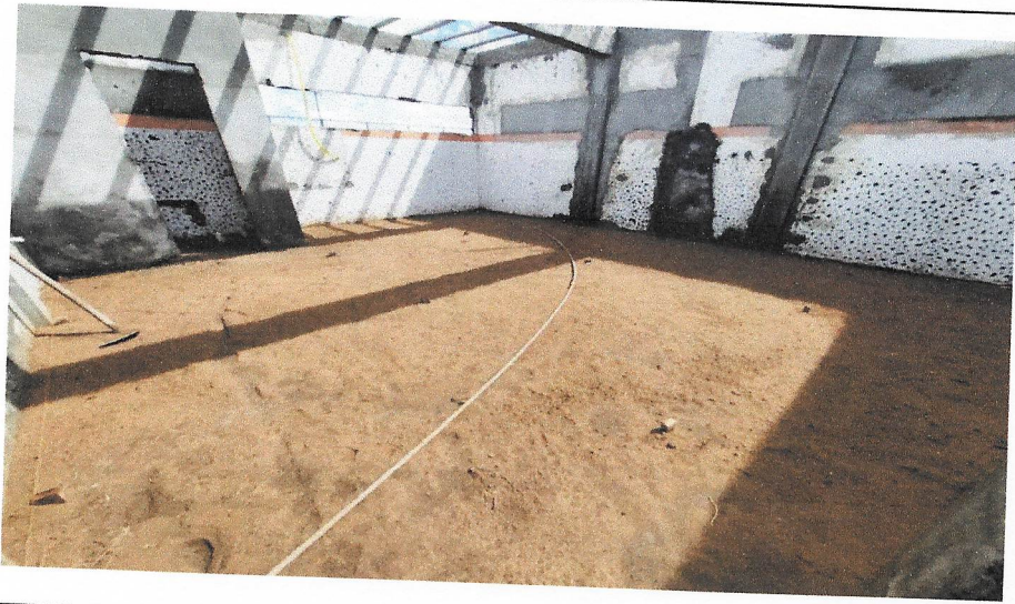
EXECUÇÃO DE REBOCO INTERNO
