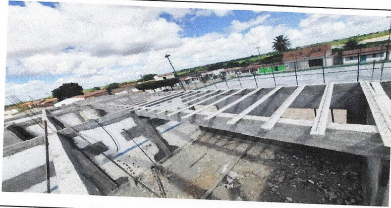
MONTAGEM DAS LAJES
